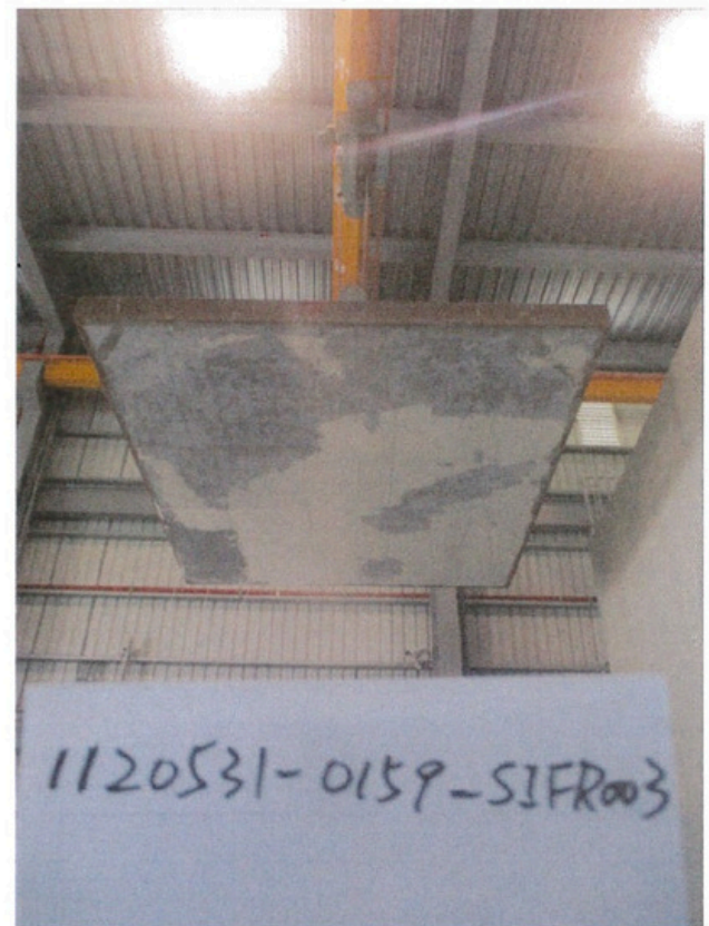
照片 6 試驗件施工完成背面
