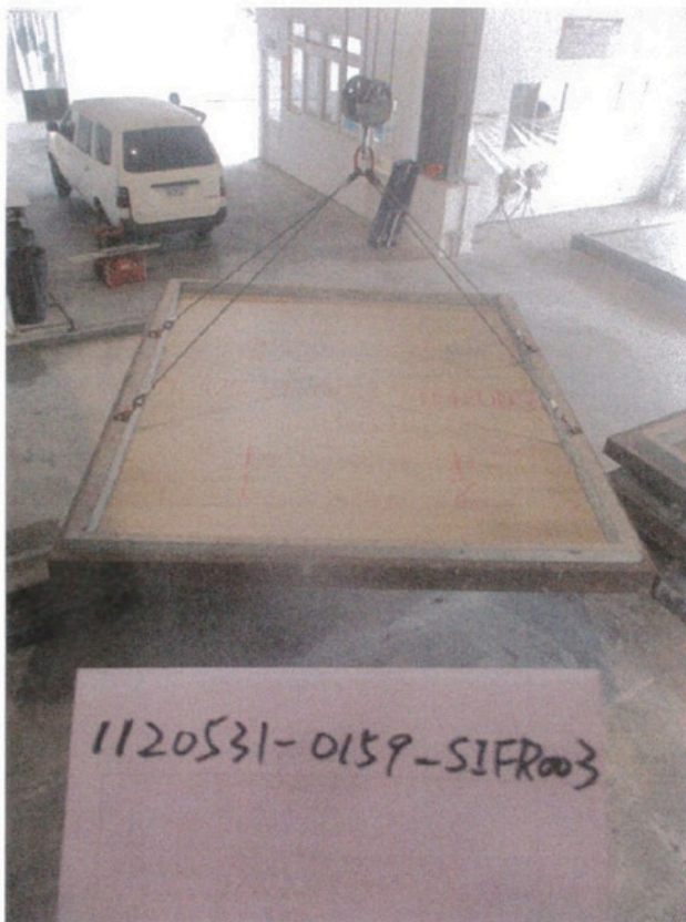
照片 5 試驗件施工完成正面
